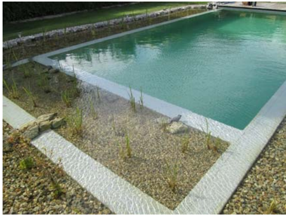
Abb.3: Im Vordergrund die Filterzone, dahinter der Schwimmbereich
